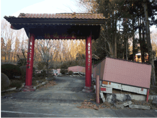
(a) 建物の倒壊（芳賀町） （西→東）
