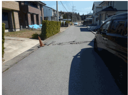
(d) 北側斜面上の道路の様子 (西→東)
