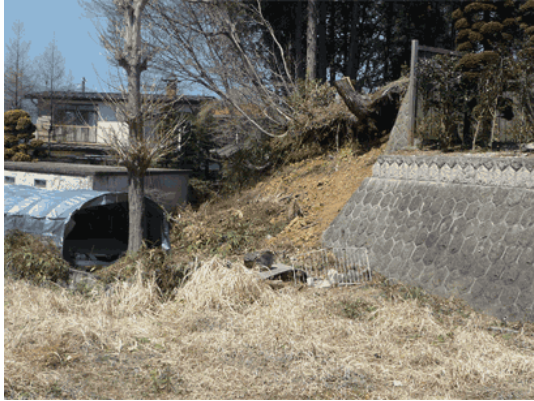
(g) 小規模な斜面崩壊 (北東→南西)
