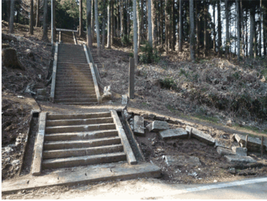
(a) 神社の階段の損壊（階段中央にクラック） （東→西）
