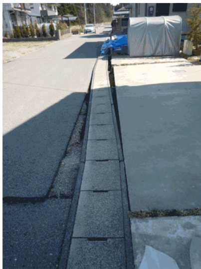
(c) 北側斜面上の道路と側溝 (西→東)
