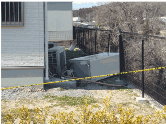
(e) 北側斜面上の住宅の様子
