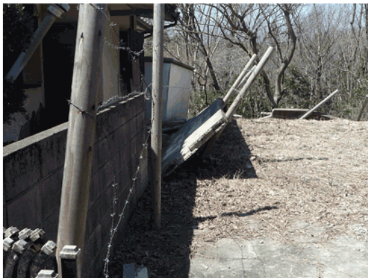
(i) ブロック塀の転倒 (南東→北西)
